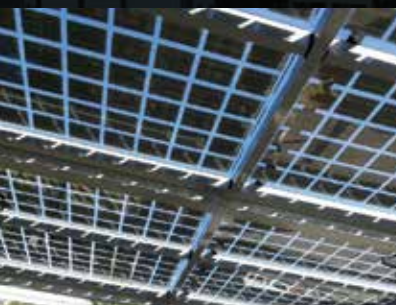
17 Φωτοβολταϊκά συστήματα ενσωματωμένα σε δομικά στοιχεία (BIPV)
